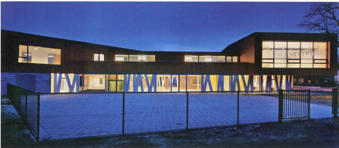
Bloemershof ist ein städtisches multifunktionales Ensemble bestehend aus einer Berufsfachschule, einer Feuerwache, einer Sporthalle und Wohnungen
